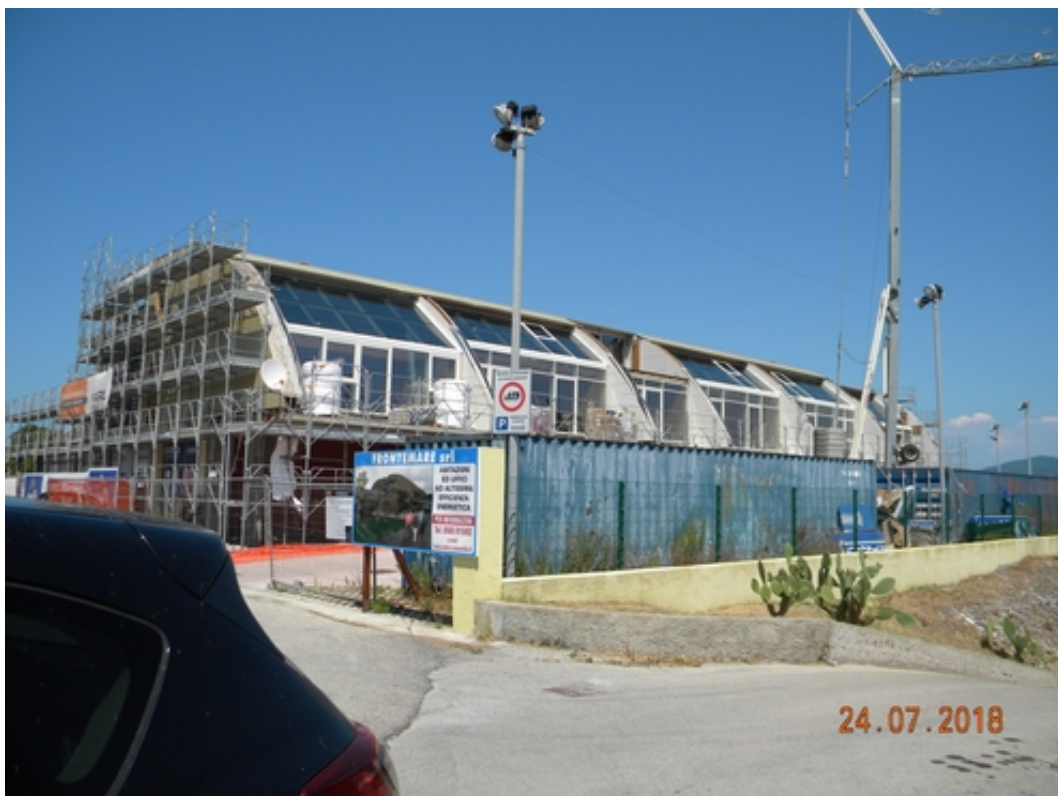
05 Edificio compreso nel Water Front attualmente in fase di sopraelevazione
