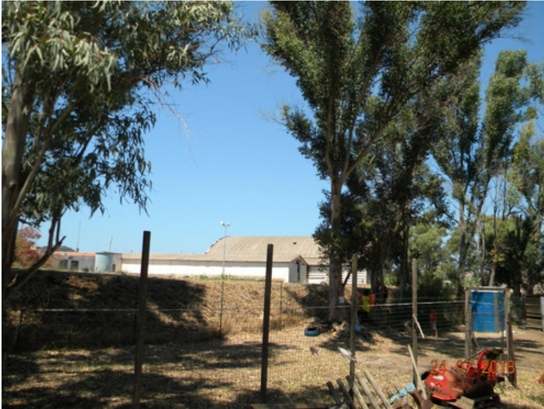
02 Edifici compresi nel Water Front confinanti all'area di intervento
