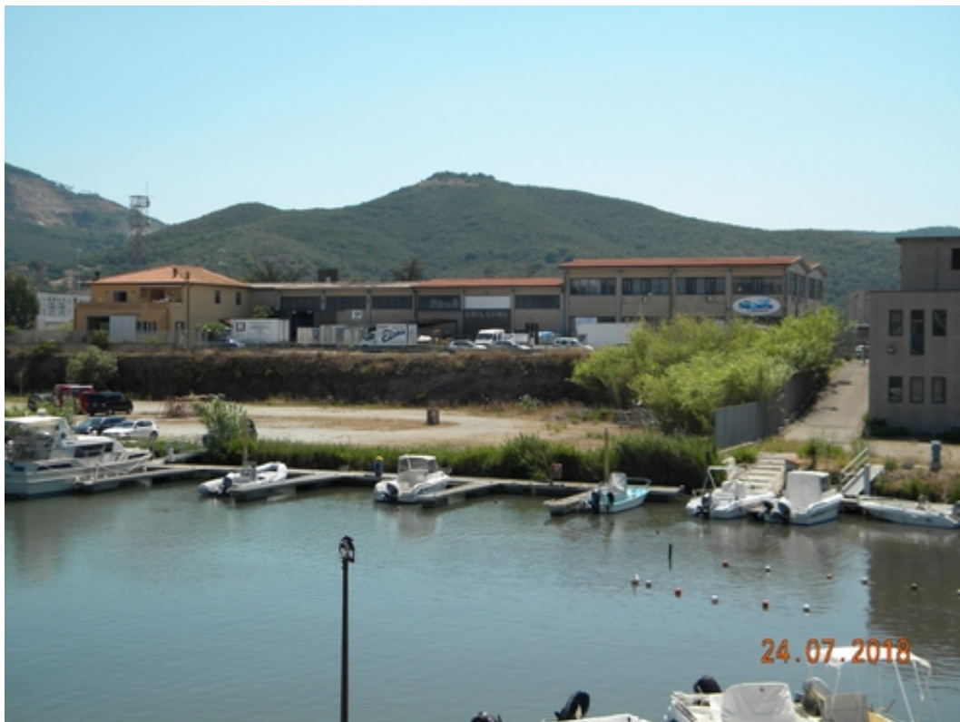
06 Edifici compresi nel Water Front confinanti all'area di intervento
