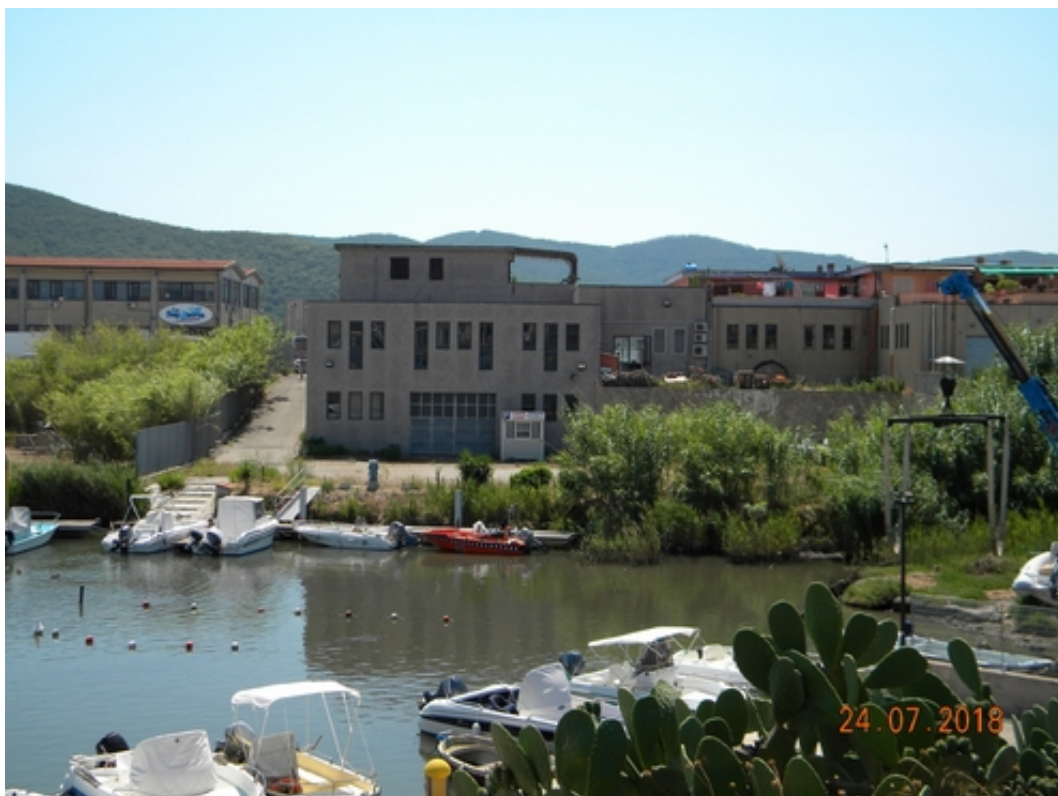
07 Edifici compresi nel Water Front confinanti all'area di intervento
