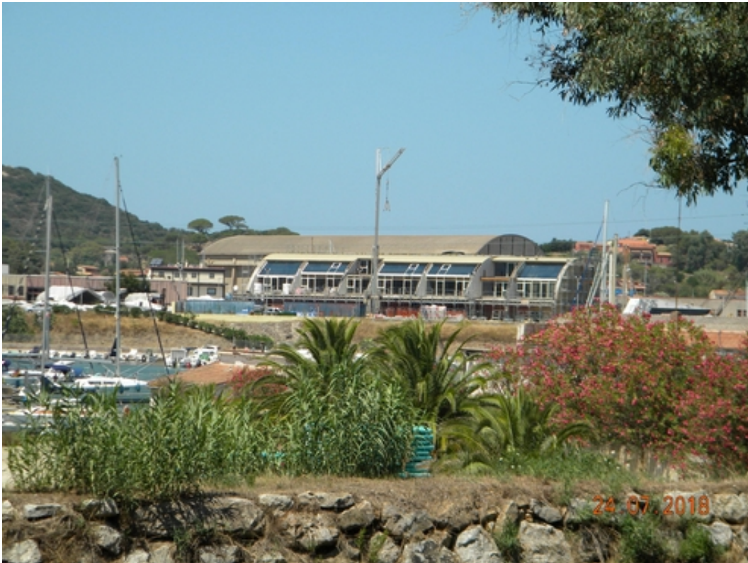
04 Edifici compresi nel Water Front confinanti all'area di intervento
