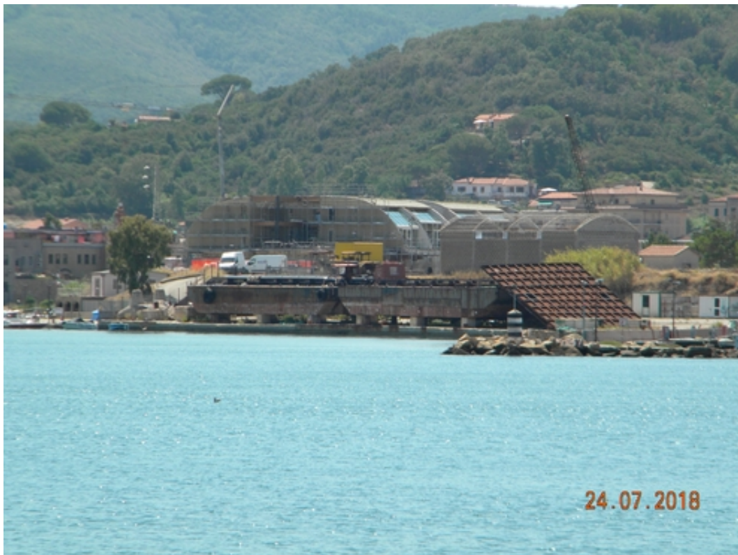
14 Edifici compresi nel Water Front attualmente in fase di sopraelevazione
