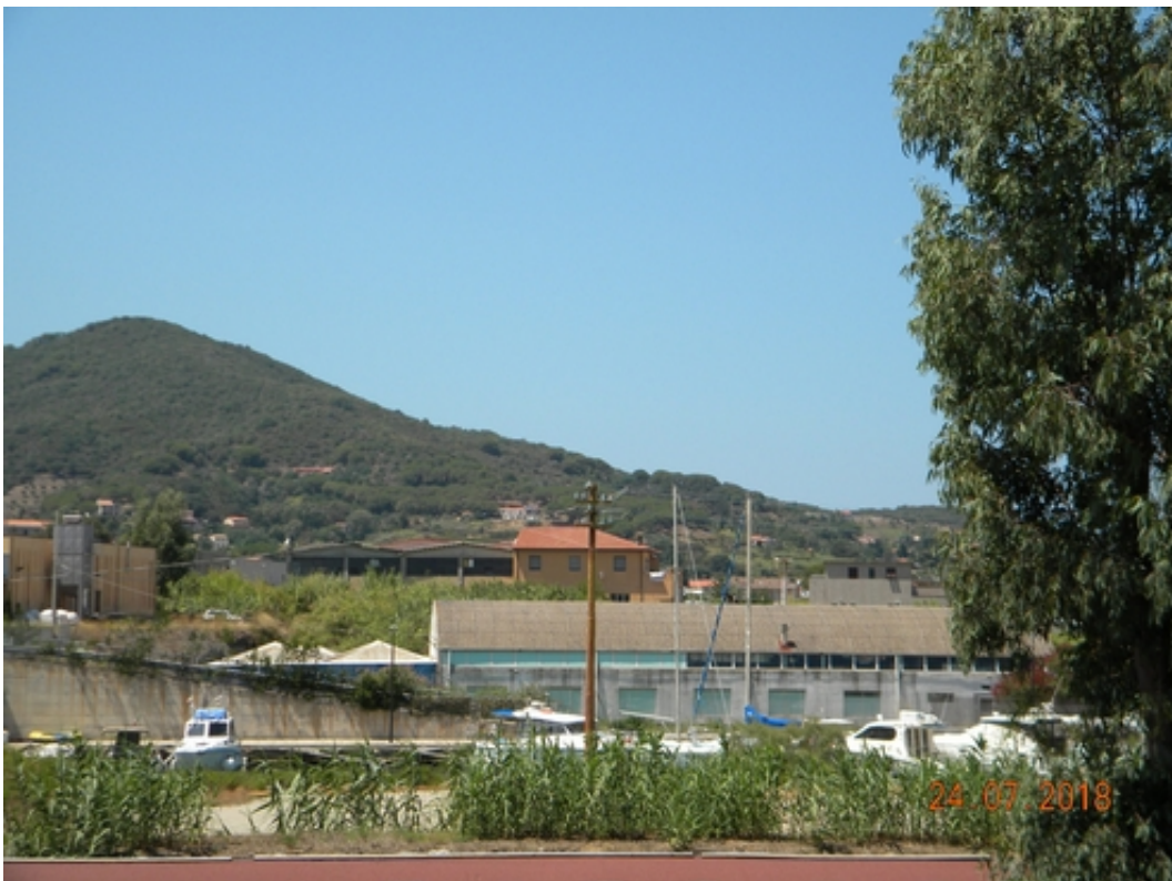
05 Edifici compresi nel Water Front confinanti all'area di intervento
