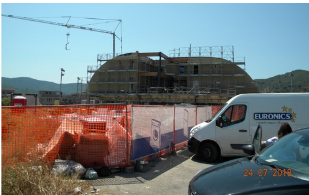
01 Edificio compreso nel Water Front attualmente in fase di sopraelevazione
