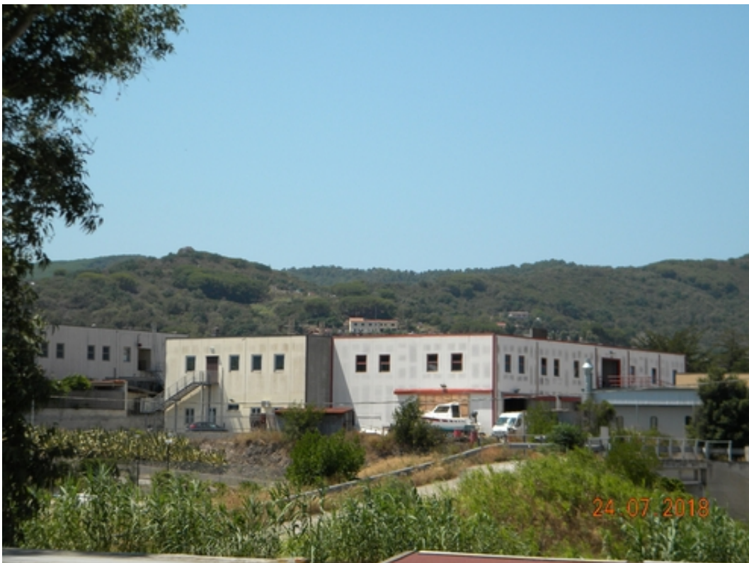
03 Edifici compresi nel Water Front confinanti all'area di intervento
