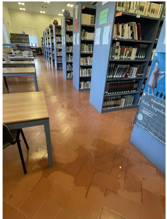
Interni biblioteca lato sud con infiltrazioni di acque meteoriche a seguito dell'evento alluvionale del 13.02.2025
