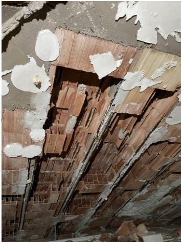
Particolare intradosso copertura
