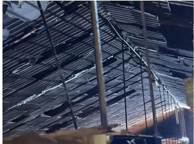
Particolare intradosso copertura
