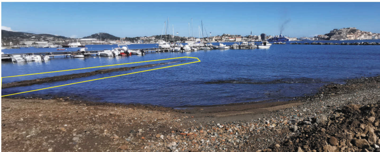
Foto n. 7 - Nel riquadro giallo si vede la condotta fognaria da demolire
